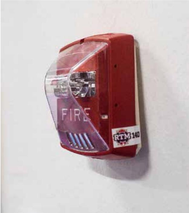
*Ilustración 1. Luz estroboscópica, cortesía de RTM Internacional*
