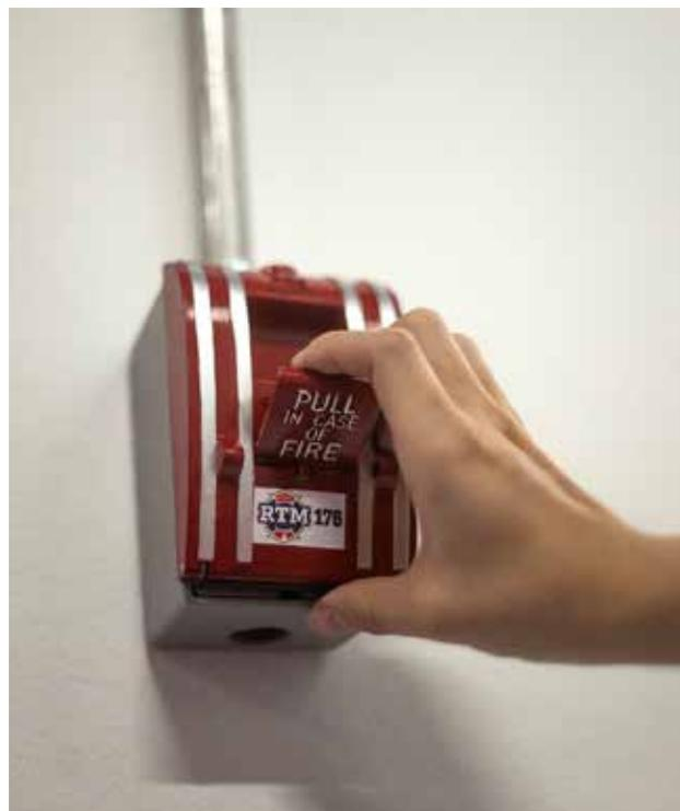
*Ilustración 3. Pulsador Manual, cortesía de RTM Internacional*
